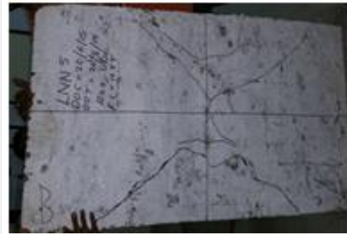
Fig 6b): Crack Patterns slab 4
