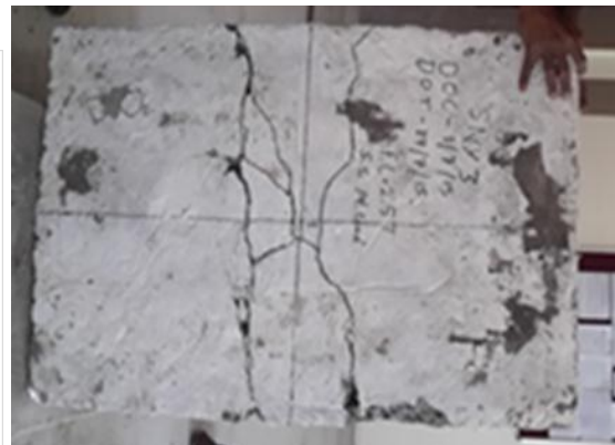
Fig 4b): Crack Patterns slab 2
