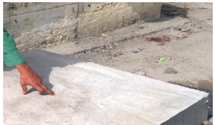
Fig: 7 Normal Slabs
