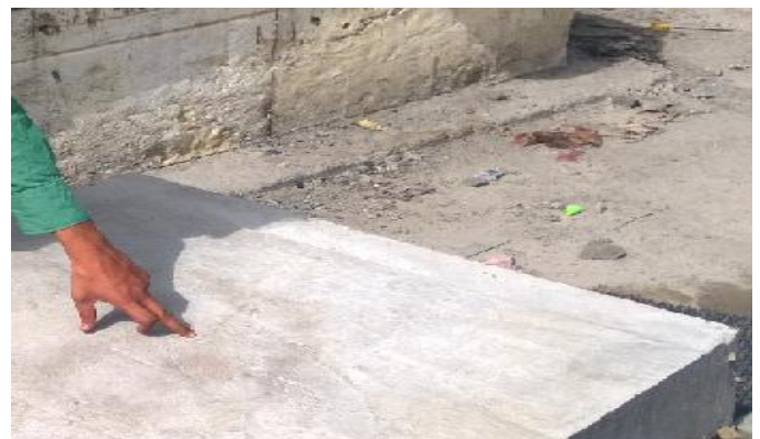
Fig: 7 Normal Slabs
